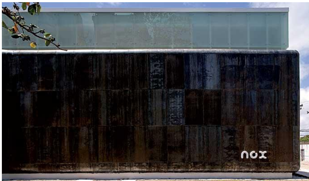
Figura 1: Fachada em aço oxidado
